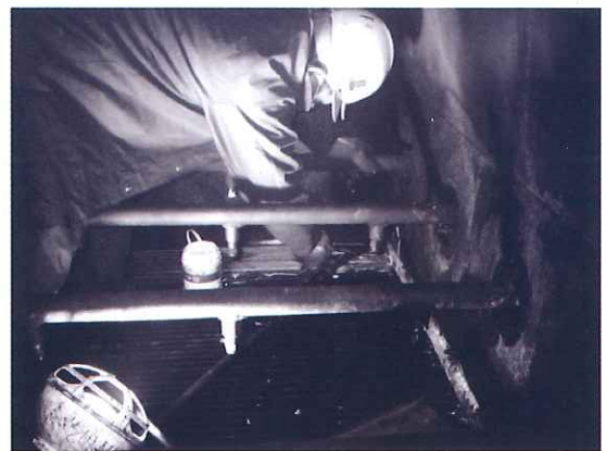
熱交換器の耐熱補強
